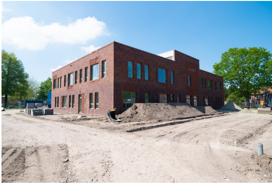
Basisschool De BERK (in aanbouw)
