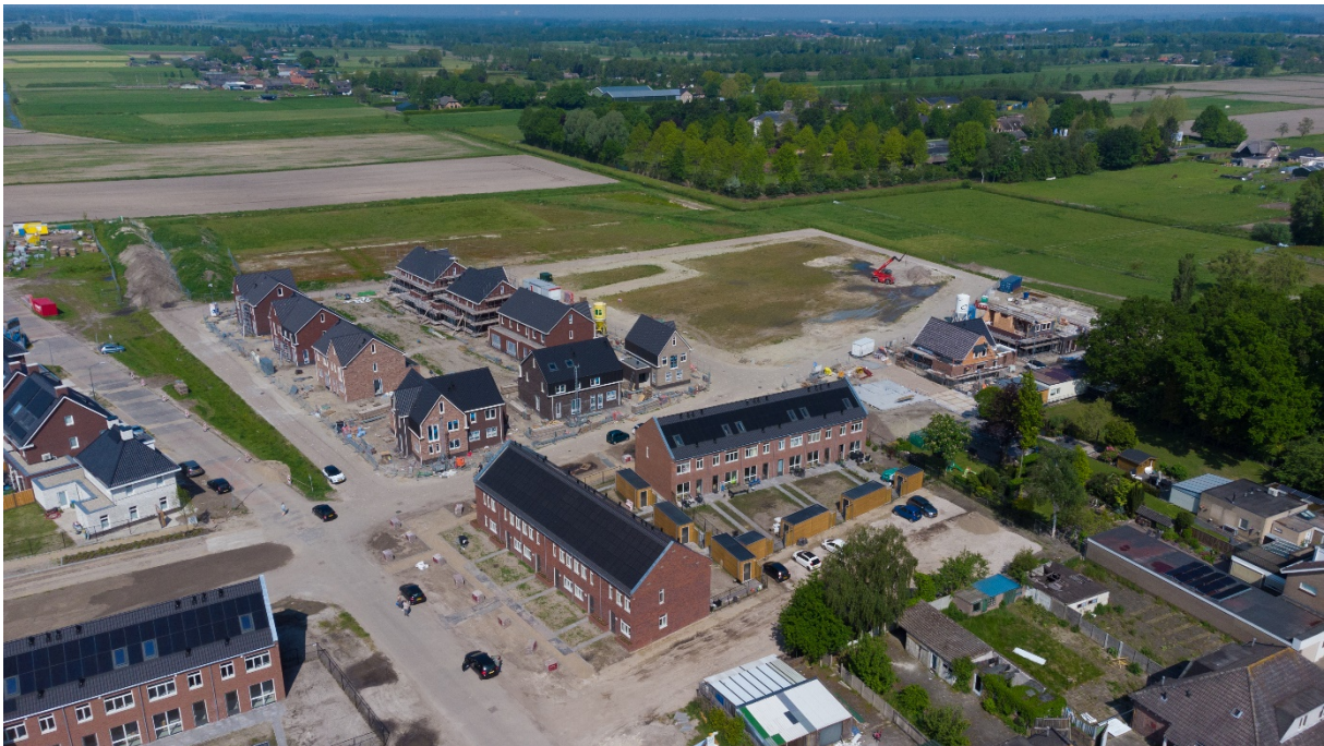
Woonwijk Westwaard in aanbouw
