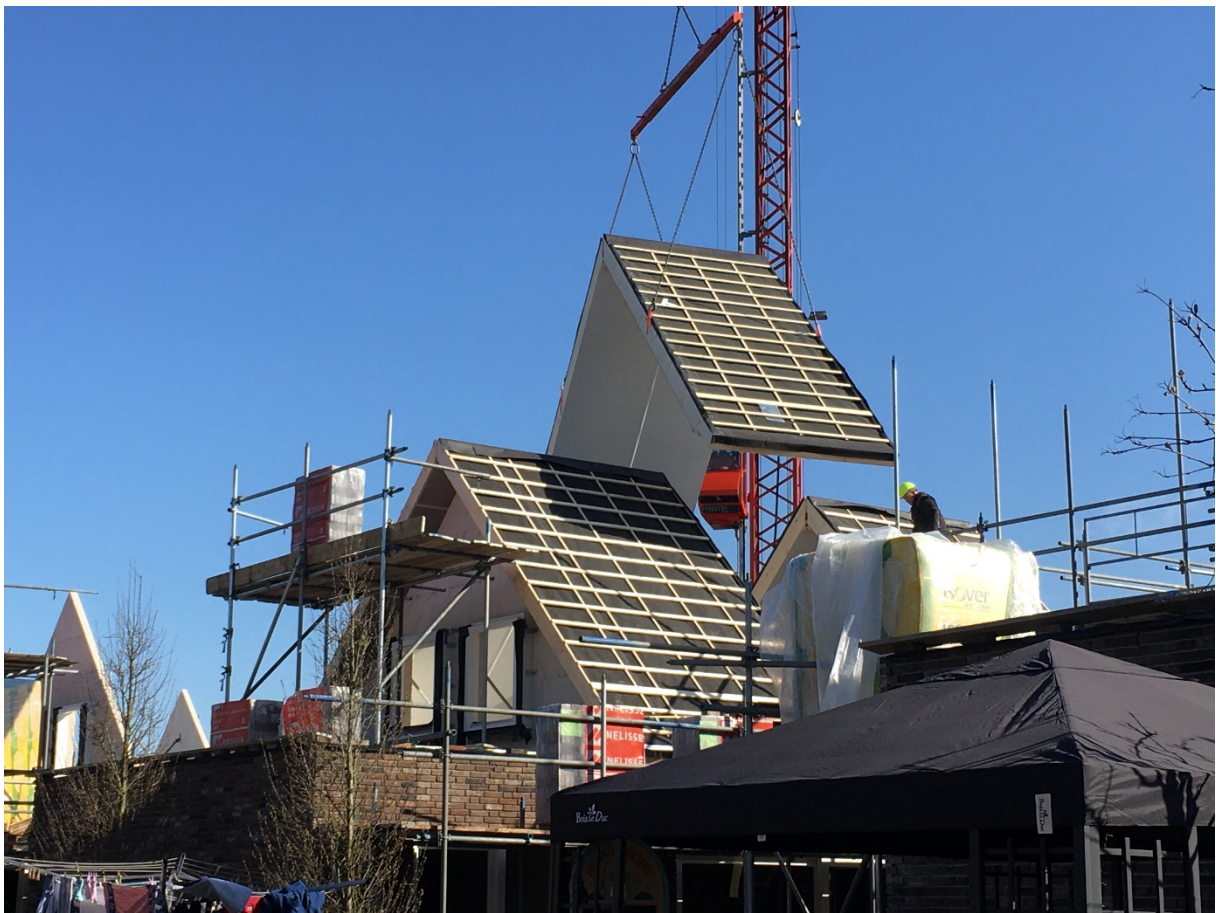
Nieuwbouwwoningen in De Dorsvlegel in de Maer.
